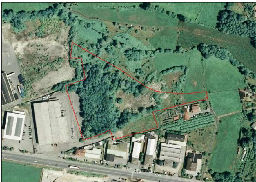
Area IP2.1 Zona Pecoul
