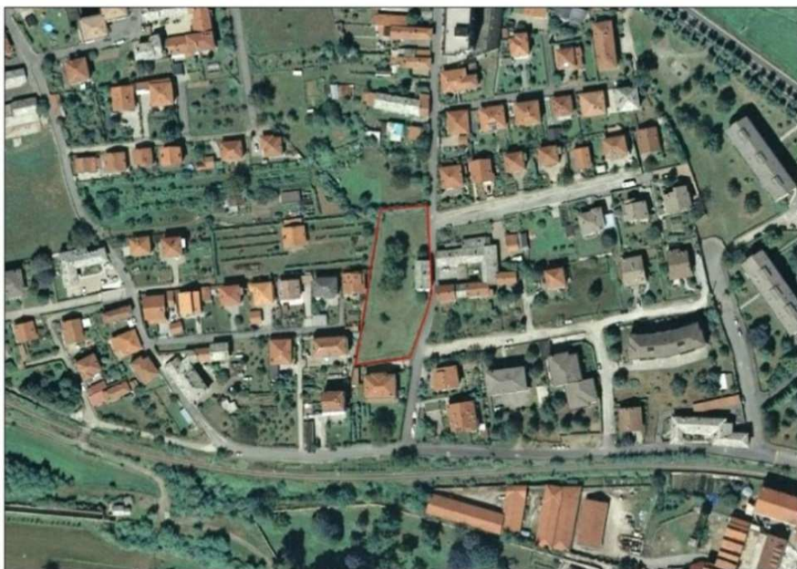
Area R7.1 Zona Ciaperassa sul confine con Torre Pellice
